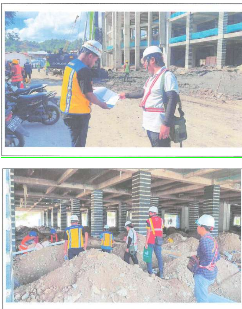
Gambar 3.11 Progres Pembangunan Rumah Sakit UPT Vertikal di Papua
